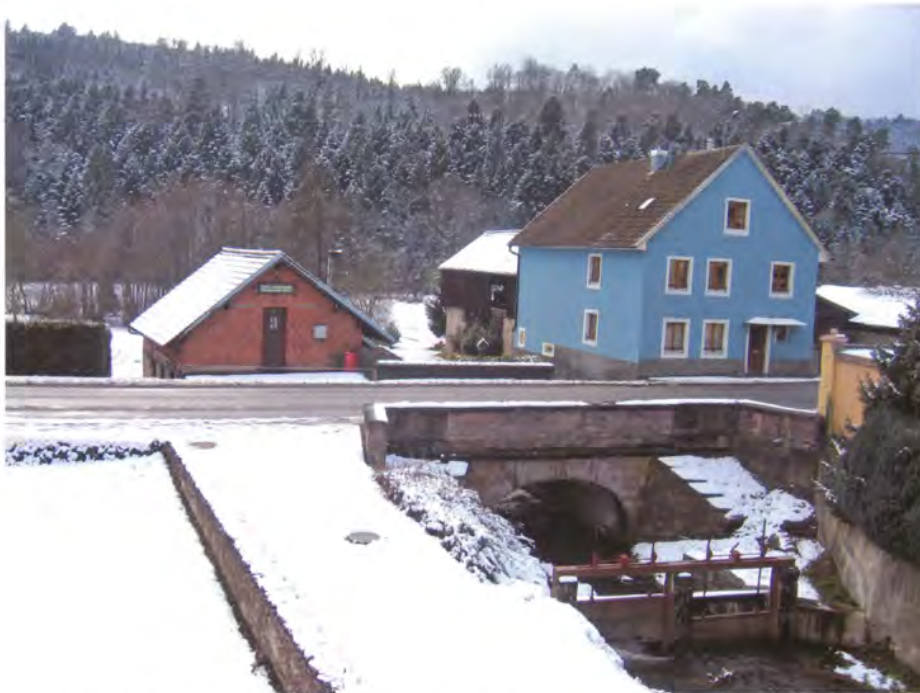
La taillanderie Lehmann en bordure de la route et du Breitenbach (AD)
