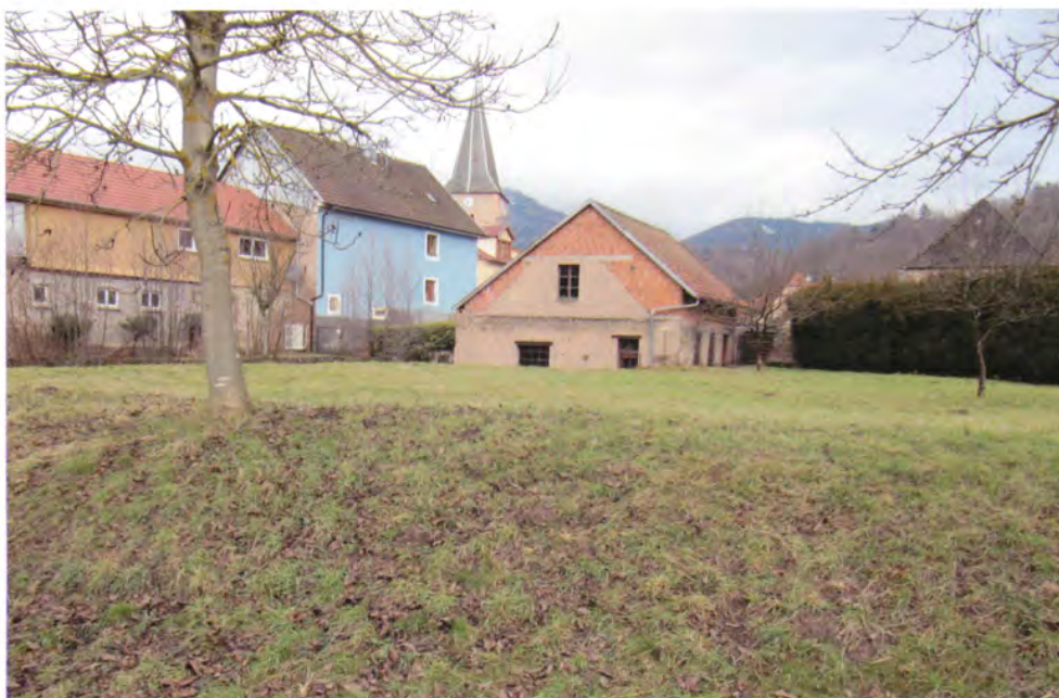
L'ancienne digue du réservoir d'eau comblé de terre (AD)
